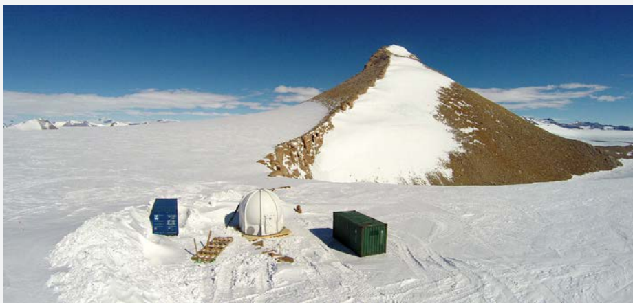
Afbeelding 1: De installatie van de radarkoepel in glasvezel aan de voet van de Utsteinen rotsmassa (december 2014). Een platform verankerd in de rots ondersteunt de koepel. Niet-magnetische geodetische palen werden binnenin de koepel gebouwd om de meetinstrumenten van het geomagnetisch veld te dragen.
